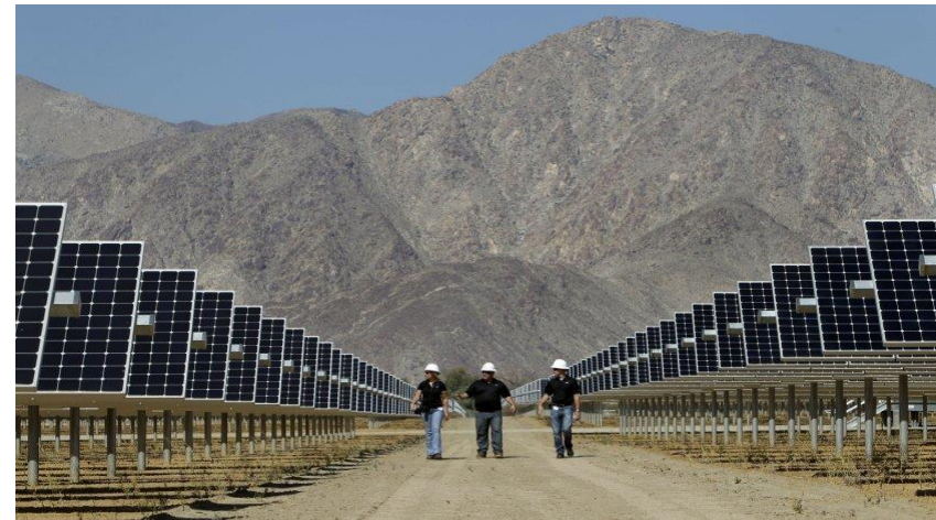
NRG Solar Borrego
